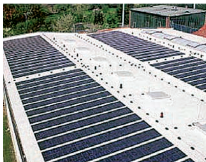
Obr. 3: Pohled na střešní plochu s PVa-Si-systémem EVALON-Solar, převzato z článku Libora Vykydala „Integrované hydroizolační fotovoltaické systémy pro ploché střechy 1“ z časopisu Stavebnictví a interiéry 9/2005 [2].
