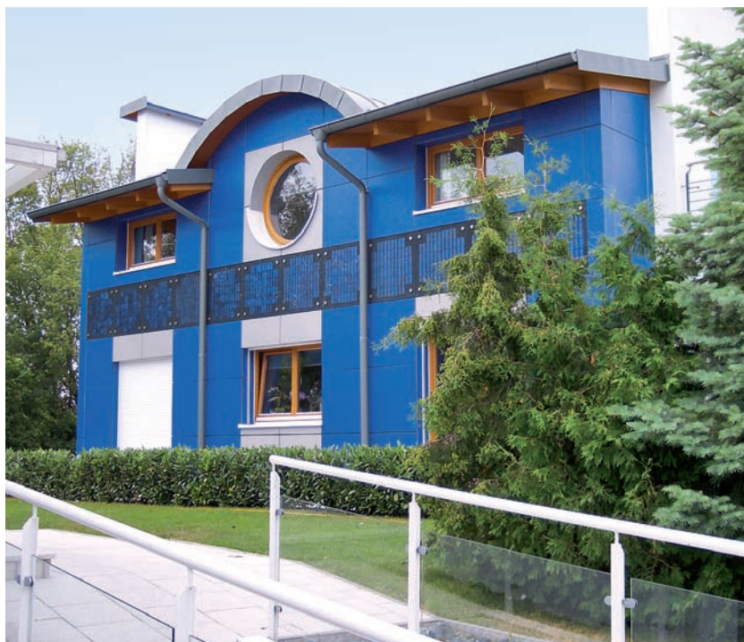
Obr. 1: Solární architektura (zde vidíme panely s fotovoltaickými články na rodinném domě) nabízí nejen nový estetický vjem, ale pro majitele znamená také rázné vykročení k nezávislému samozásobení tepelnou a elektrickou energií. Mnozí investoři a stavebníci její akcentací vyjadřují také svůj postoj k životu, odpovědnosti za ochranu přírody a k dnešní i budoucí společnosti. Snímek je ze stálé výstavy vzorových domů Modrá Laguna ve Vídni. Foto redakce.
