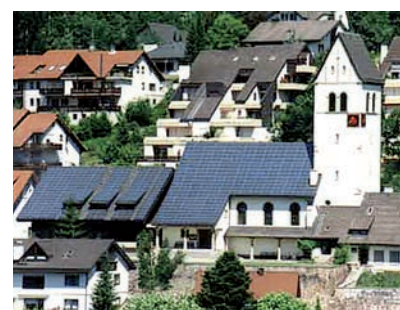
Obr. 5: Kostel a přilehlý obecní úřad v Schönau, Baden-Württemberg, Německo. Solární zastřešení ukazuje, že se požadavky památkové ochrany a nové stavebně-energetické technologie nemusí jen vylučovat.
